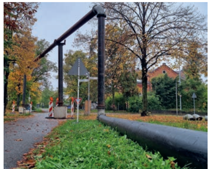
Rohrbrücke am Übergang Schulstraße (Foto: Markus Hehn/Stadtverwaltung Pfullingen)
