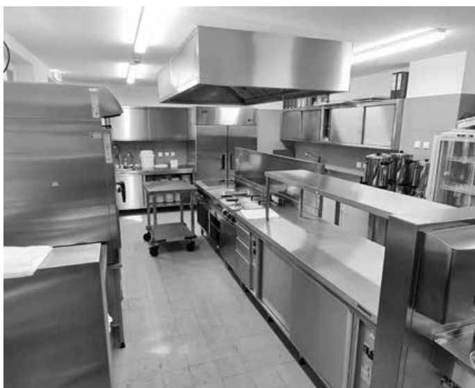
Die neue Catering-Küche.
