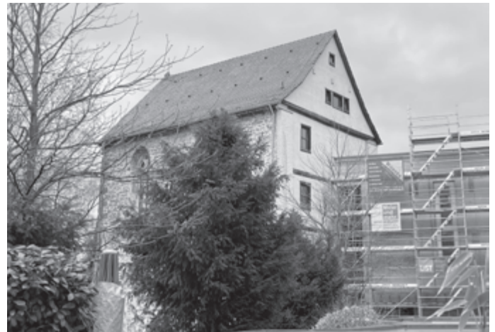
Von rechts her kommend nimmt der Anbau, der die historische Klosterkirche unter anderem um ein Treppenhaus ergänzen wird, deutlich Konturen an. (Foto: Geng/Stadt)
