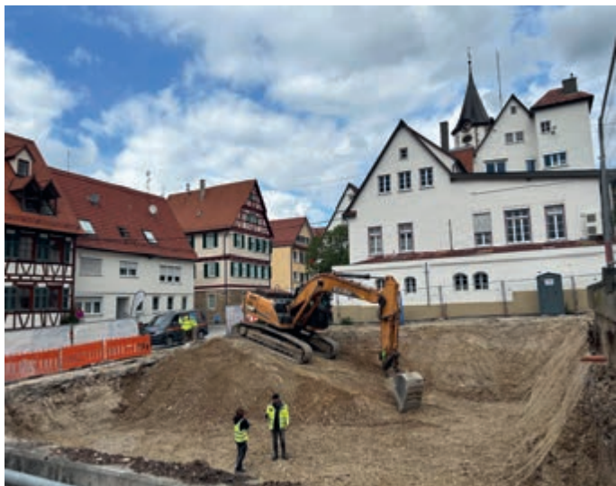
Baugrube hinter dem Rathaus II - hier wird das Rathausergänzungsgebäude seinen Platz haben. (Foto: Hehn/Stadt)
