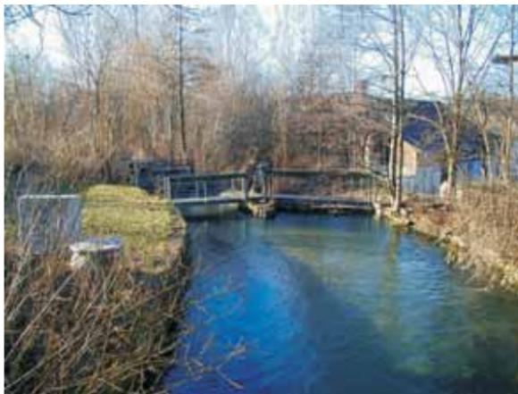
Ohne dieses Wehr wäre die Versorgung des Kanals nicht möglich, da das Gelände hier eine starke natürliche Stufe bildet. Das Wasser würde dem Hauptbett folgen. Im Kanal muss das Wasser weiterhin „oben“ geführt werden, damit genügend Kraft zum Antreiben einer Turbine vorhanden ist.
